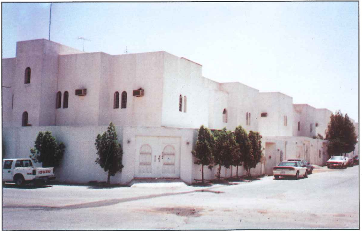
مباني المجمع السكني بحي الأزدهار شمال مدينة الرياض
