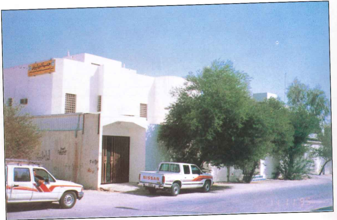
مبنى مقر فرع الجمعية بغرب الرياض (بظهرة البديعة)
