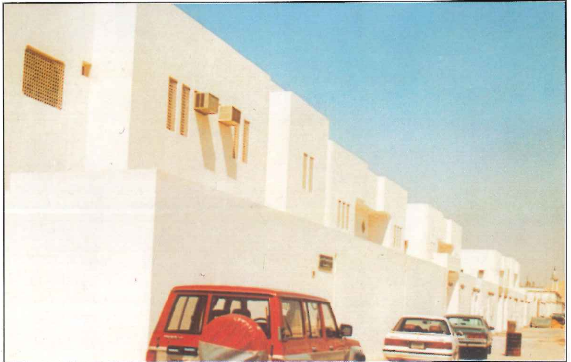
مباني عدد ١٠ فلل سكنية استثمارية شمال مدينة الرياض بحي المصيف
